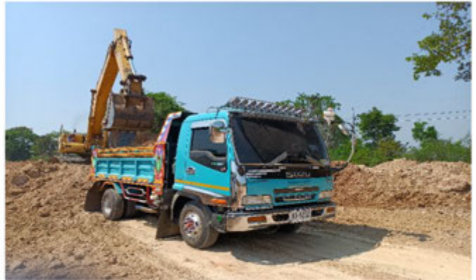
ภาพ 1.1 งานฝังกลบขยะ ⇨ โดยใช้รถแบคโฮและสิบล้อเตรียมดินเพื่อฝังกลบขยะ
