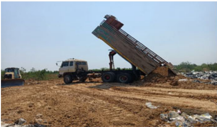
ภาพ 1.2 งานฝังกลบขยะ ⇨ โดยใช้รถสิบล้อขนดินเพื่อฝังกลบขยะ
