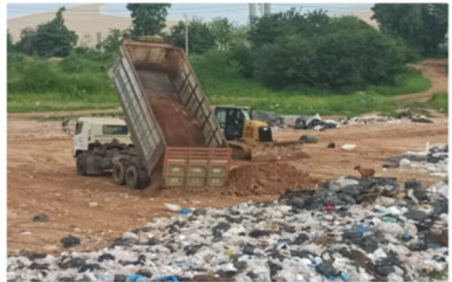
ภาพ 1.2 งานฝังกลบขยะ ⇨ โดยใช้รถสิบล้อขนดินเพื่อฝังกลบขยะ
