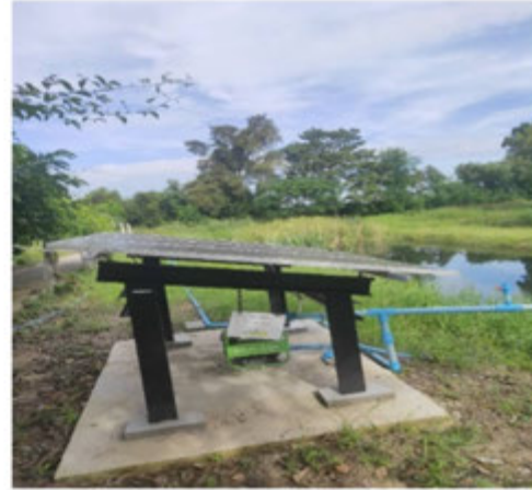
ภาพประกอบ โครงการติดตั้งบึงสูบน้ำระบบพลังงานแสงอาทิตย์ที่สวนสมุนไพรจากน้ำที่ผ่านการบำบัดแล้ว
