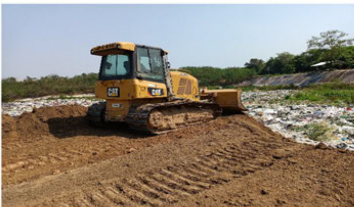
ภาพ 1.3 งานฝังกลบขยะ ⇨ โดยใช้รถ BULLDOZER ฝังกลบขยะพร้อมบดอัดความหนาแน่นขยะ
