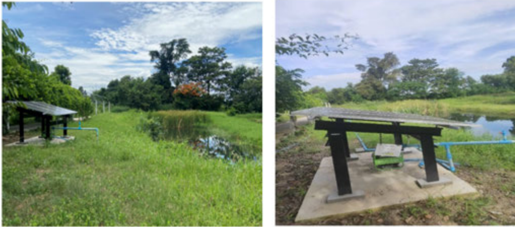
ภาพประกอบ โครงการติดตั้งบึงสูบน้ำระบบพลังงานแสงอาทิตย์ที่สวนสมุนไพรจากน้ำที่ผ่านการบำบัดแล้ว
