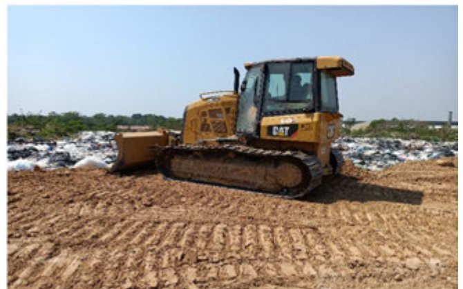
ภาพ 1.3 งานฝังกลบขยะ ⇨ โดยใช้รถ BULLDOZER ฝังกลบขยะพร้อมบดอัดความหนาแน่นขยะ
