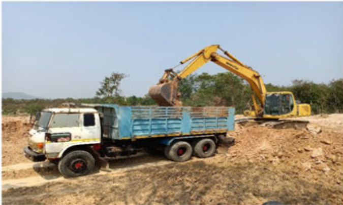
ภาพ 1.1 งานฝังกลบขยะ ⇨ โดยใช้รถแบคโฮและสิบล้อเตรียมดินเพื่อฝังกลบขยะ
